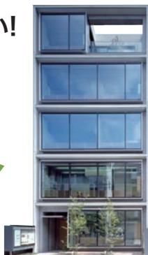
勁草学舎外観
