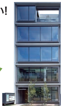
勁草学舎外観
